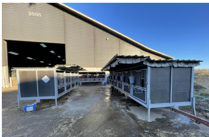
Bygning 10, kalvevogne m. enkeltdyrsbokse, i alt 13 pladser
