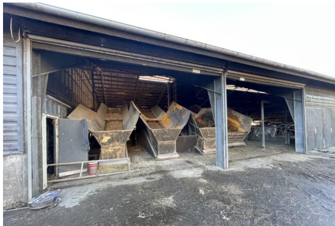
Bygning 8 – påslag til foderanlæg
