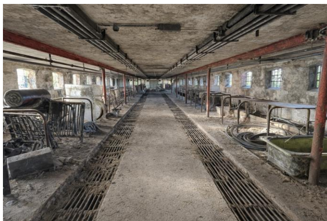
Bygning 3, gl. kostald
