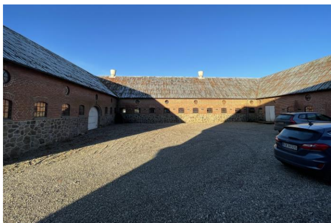
Bygning 3 – mellem bygning 5 og 2
