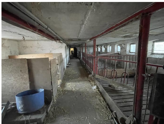
Bygning 2 – gl. stald
