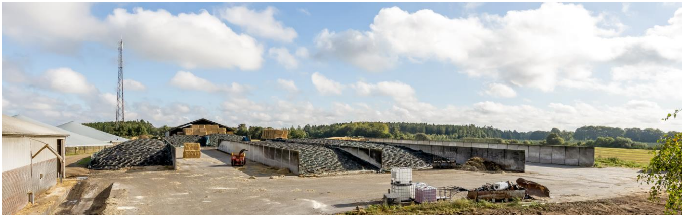
Plansiloanlæg T 15 ved foderlade og halmhus
