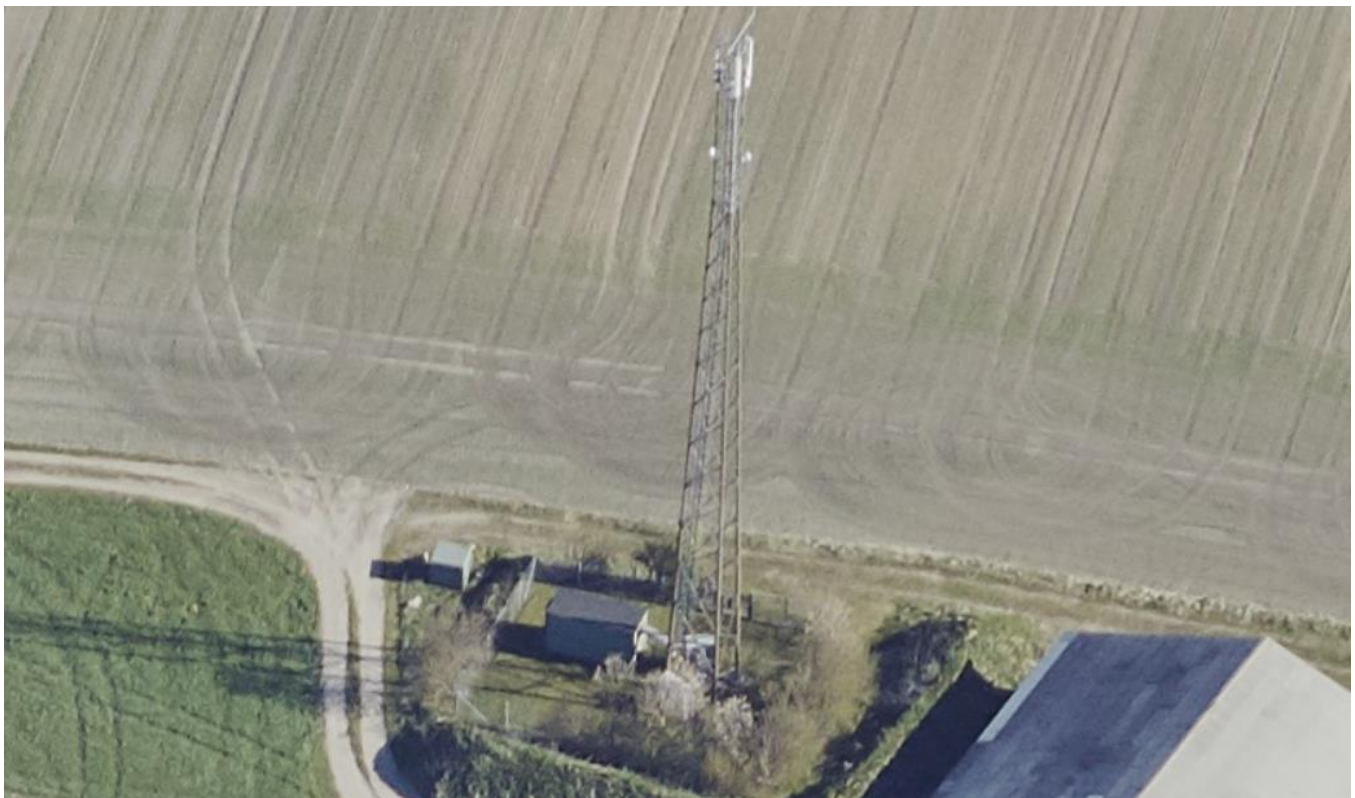
Bygning 12 samt T 7, T 8, T 9 og T 10 - Antennemast og anlæg
