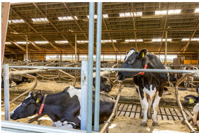
Bygning 11, sengebåse og spalter
