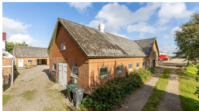
Bygning 2 med indkørsel til gårdspladsen
