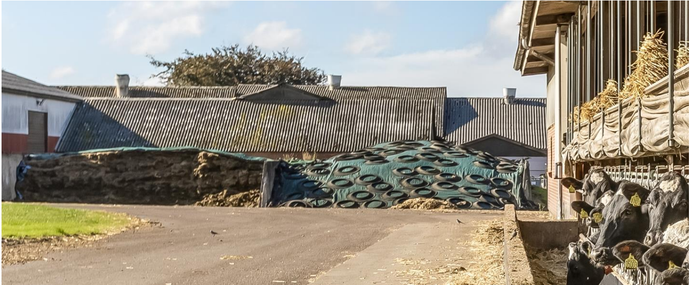
Plansiloanlæg T 14 ved bygning 5 og bygning 11
