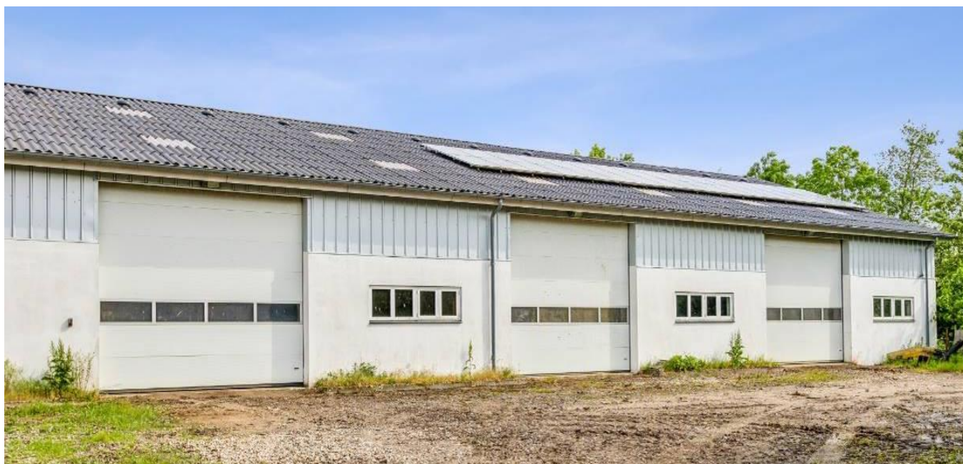
Bygning 6. Hestestald og maskinhus/lager mv.
