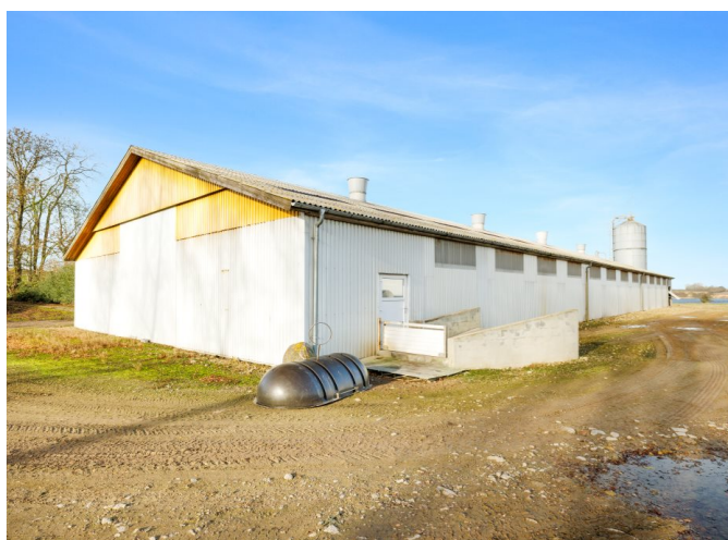
Slagtesvinestald med udleveringsrampe
