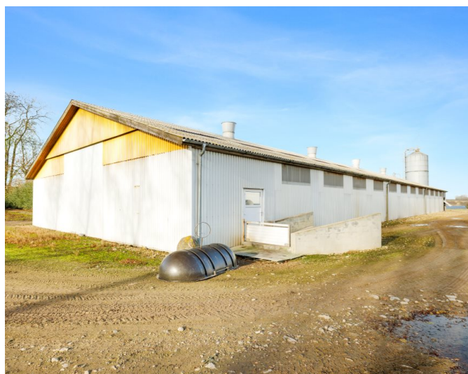
Slagtesvinestald med udleveringsrampe
