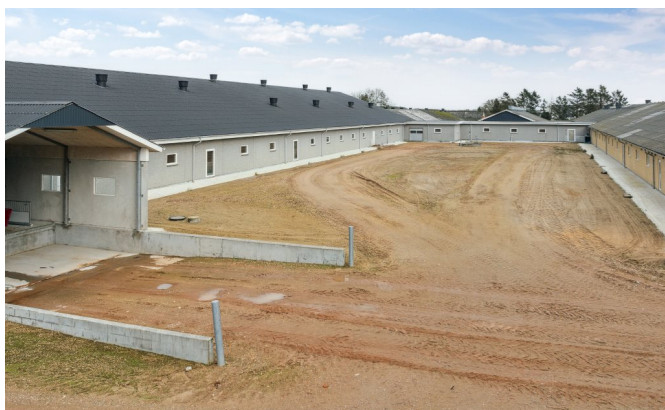
Staldbygninger fra hhv. 2020 - 2014
