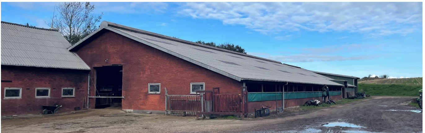
Kostalden bygning 7 samt enden af bygning 2 med malkestald
