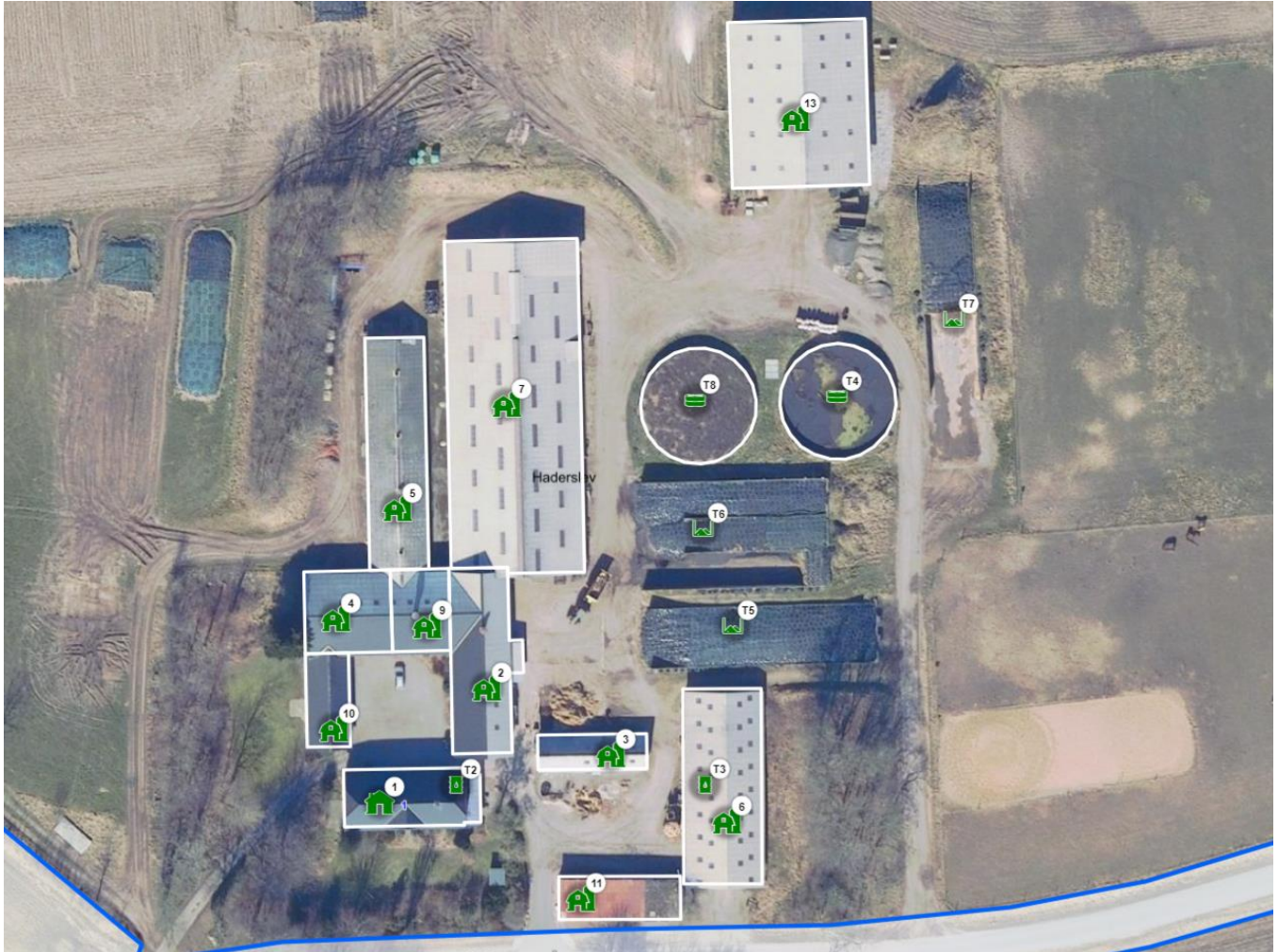
Bygningsnr. iflg. BBR – se nærmere beskrivelse nedenfor
