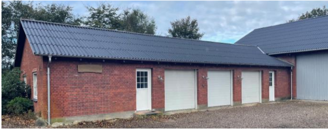
Bygning 10 og port til bygning 4
