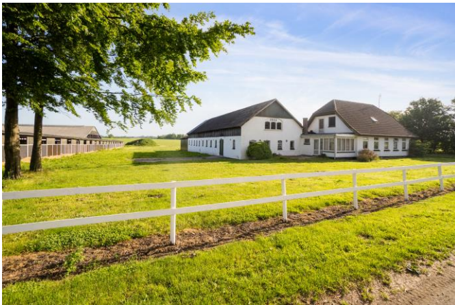
Bygning P og R
