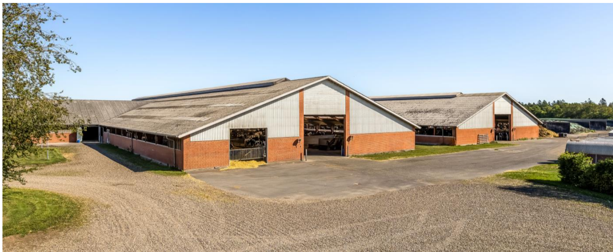
Ko- og kviestald (bygning 11 og 12) set fra stuehusets gårdsplads
